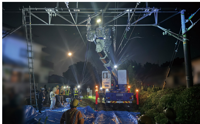
多機能鉄道重機(零式人機 ver.2.0 をベースとした日本信号による製品)の初導入 (写真提供：JR西日本)
