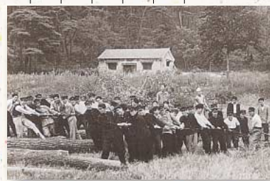
写真1：衣笠球場造成工事
