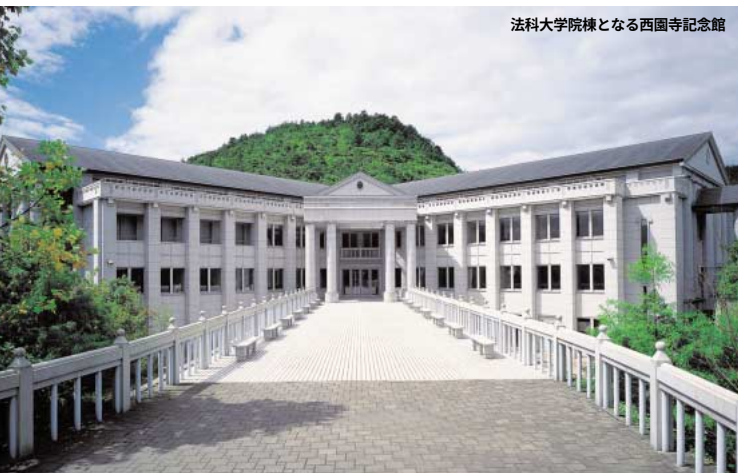
法科大学院棟となる西園寺記念館
