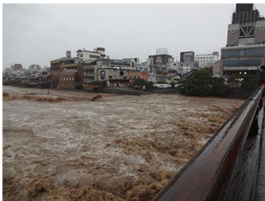
H25.9 台風18号 三条大橋下流の状況
