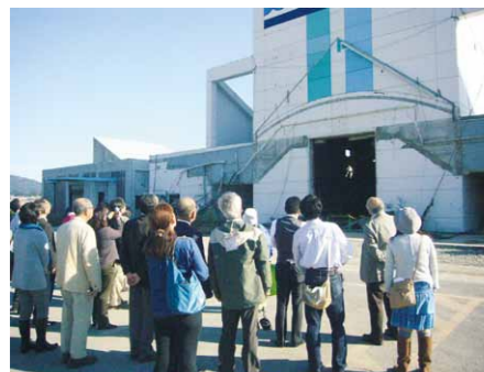
陸前高田市の津波被害に遭った道の駅
